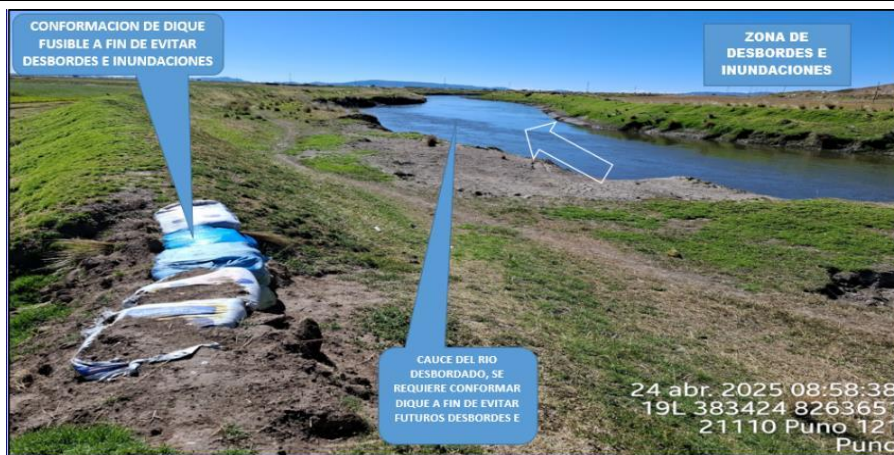
FIGURA 1 y 2 : TRAMO CRÍTICO EN EL RÍO ILLPA, EN EL SECTOR BOMBACHUPA, DISTRITO DE PAUCARCOLLA, PROVINCIA DE PUNO - PUNO. NOTESE, LA MARGEN AMBAS MARGENES DEL RÍO ILLPA QUE REQUIERE LA CONFORMACION DEL DIQUE FUSIBLE PARA EVITAR EL DESBORDE E INUNDACIONES.
